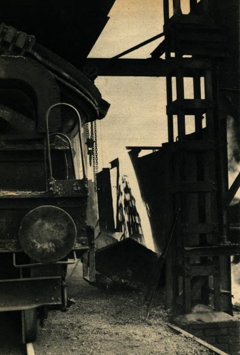
Das obere Bild zeigt wie die glühende Hochofenschlacke aus der Schlackenpfanne in die Granulieranlage gekippt wird. Unten rechts wird die granulierten Schlacke mit Wasser gekühlt und in den Selbstentlader gefüllt.
