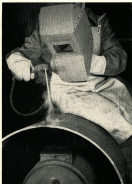
Kein „Herr vom andern Stern“; hinter der Schweißmaske verbirgt sich Paul Runke von der Mechanischen Werkstatt der Westfalenhütte. Er schweißt gerade eine Gichtgasleitung von einem Meter Durchmesser mit Agil-Elektroden
