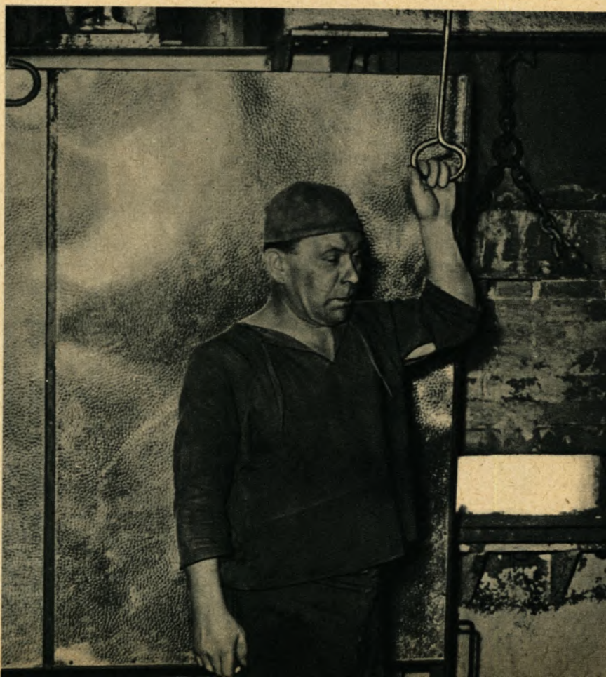
Franz Javzewsky, Ofenmann, vor dem Strahlenschutzblech (Aluminiumblende) beim Bedienen einer Ofentür-Zugvorrichtung im Hohenlimburger Walzwerk
