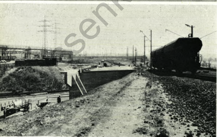
Ein Teil der Aufstellgleise oberhalb des Ablaufbergs Meerbergstraße konnte bereits in Betrieb genommen werden. Am linken Bildrand das Oxygenstahlwerk Beeckerwerth.
