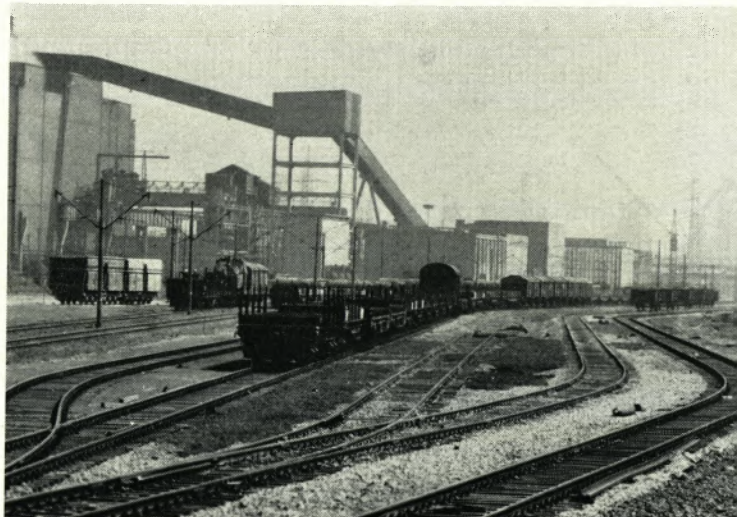
Ein Teil der Aufstellgleise oberhalb des Ablaufbergs Meerbergstraße konnte bereits in Betrieb genommen werden. Am linken Bildrand das Oxygenstahlwerk Beeckerwerth.
