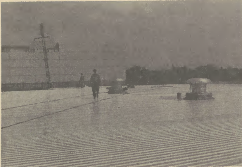
Das Verlegen von Dachblechen auf einer Halle in Amsterdam.
