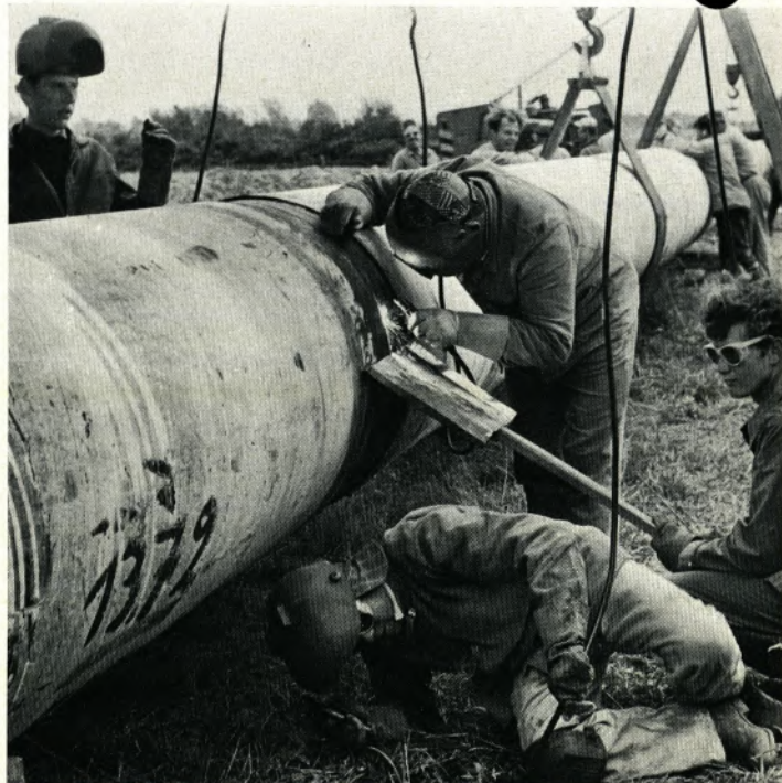
Vier Fallnahtschweißer legen die erste Schweißnaht, in der Fachsprache Wurzel-schweißung genannt.
