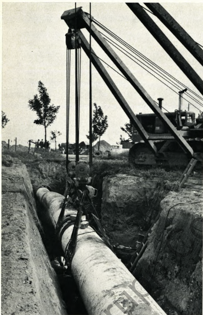
Vier Fallnahtschweißer legen die erste Schweißnaht, in der Fachsprache Wurzel-schweißung genannt.
