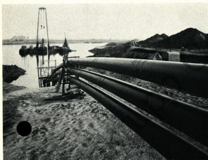
Für die Hochdruck-Erdgasversorgung Hamburgs lieferten wir kunststoffummantelte Rohre, die an mehreren Stellen der Norderelbe als Düker verlegt wurden. Seite 18
