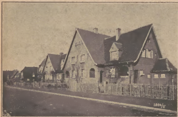
Kolonie Steinfühlerweg, neuere Bauweise
