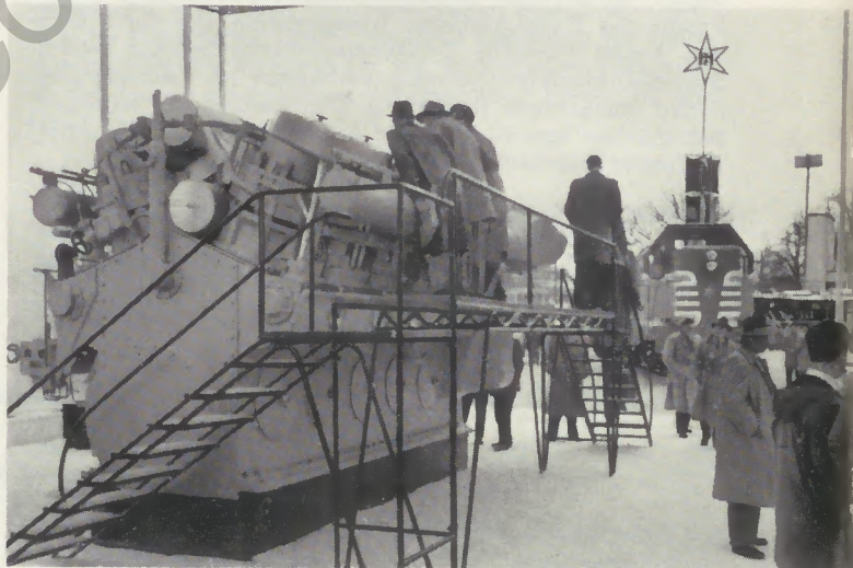
Henschel-Schiffsdiesel, 3000 PS (Lizenz SEMT-Pielstick)
