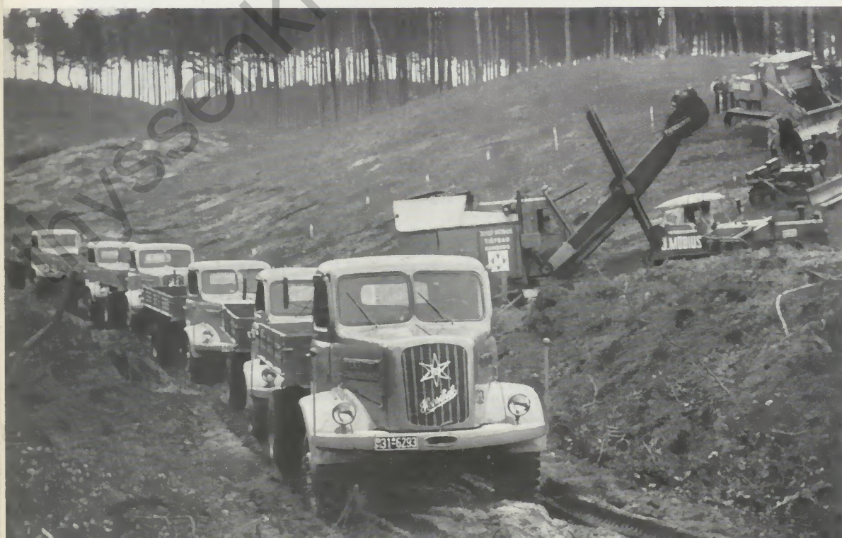
Henschel-Allrad-Kipper auf der Großbaustelle Geesthachter Pumpspeicherwerk der Hamburger Elektrizitätswerke
