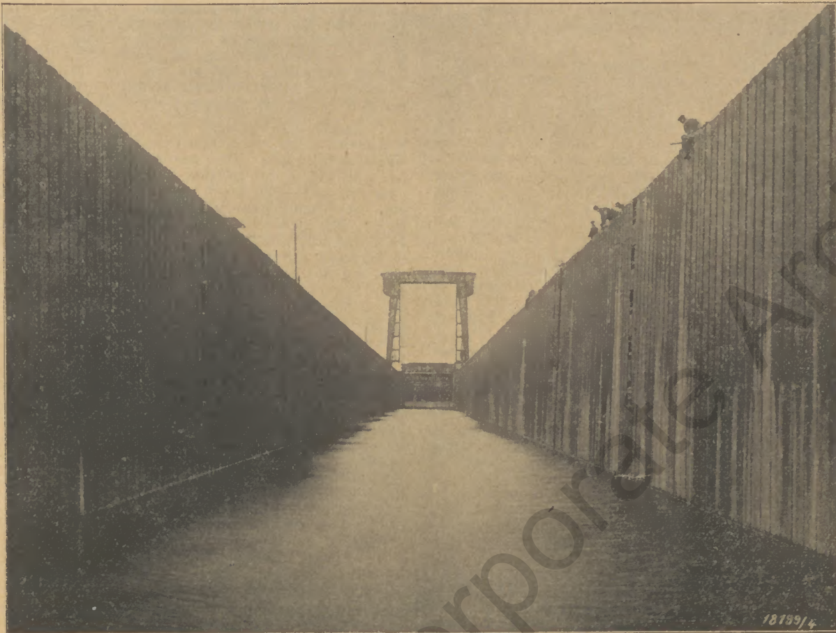
Schleuse Hünxe des neuen Lippe-Seitenkanals Wesel-Datteln, hergestellt aus Spundwandbleisen „Varssen“ der Dortmunder Union
