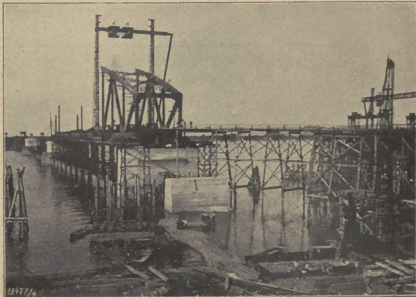
Montage des ersten Ueberbaues der Strombrücke — Stand der Arbeiten am 21. Aug. 1929
