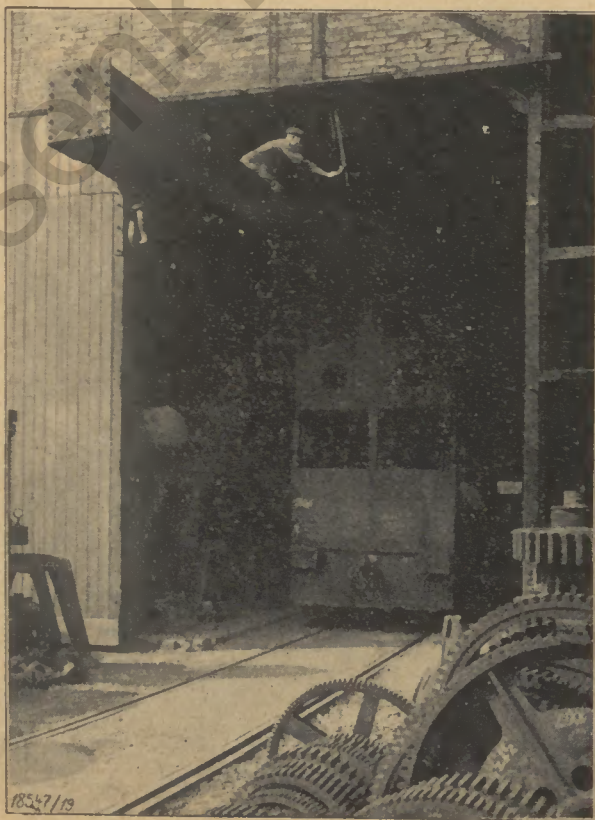
Hände weg von elektrischen Leitungen!
