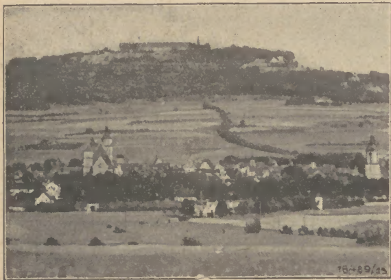
Bild 9: Weissenburg, Gesamtansicht mit Wülzburg
