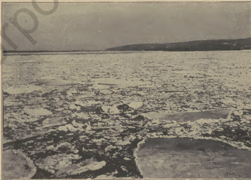
Eisgang an der Baustelle — Aufnahme vom 17. März 1929
