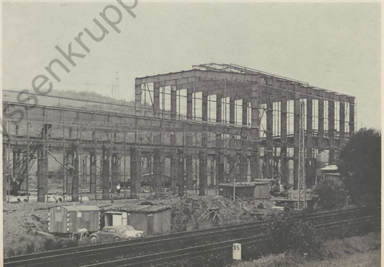
Stahlkonstruktion für die neue Bandverzinkungs- anlage im Werk Eichen. Die Aufnahme entstand vier Wochen nach Montagebeginn. Sie zeigt den niedrigen Hallenteil vor der Errichtung der hohen Rahmenkonstruktion. Montage der vollwandigen Dachbinder, die mittels Autokran direkt vom Waggon abgenommen und auf die eingespannten Stützen aufgesetzt werden.
