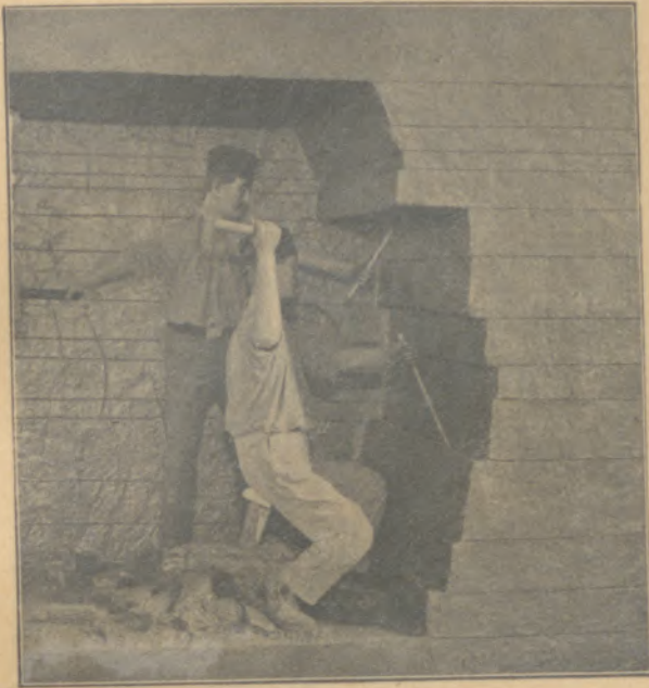
Abb. 14: Schlagendes Bohren: Querschlagbetrieb, Bohren mit Fäustel und Meißel
