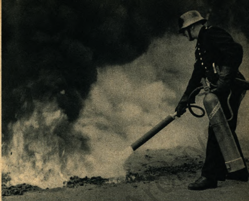
Gegen einen Ölbrand geht hier ein Werkschutzmann mit einem Kohlensäurelöscher vor
