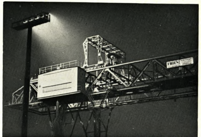
Hier eine wirkungsvolle Nachtaufnahme: Die Kranbahn der neuen Sinteranlage der Phoenix-Rheinrohr AG., Ruhrort, von der Helmholtzstraße aus gesehen
