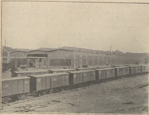
Der Wagenbau der Dortmunder Union, in dem jetzt die größte Fischräucheranlage des Kontinents untergebracht werden soll
