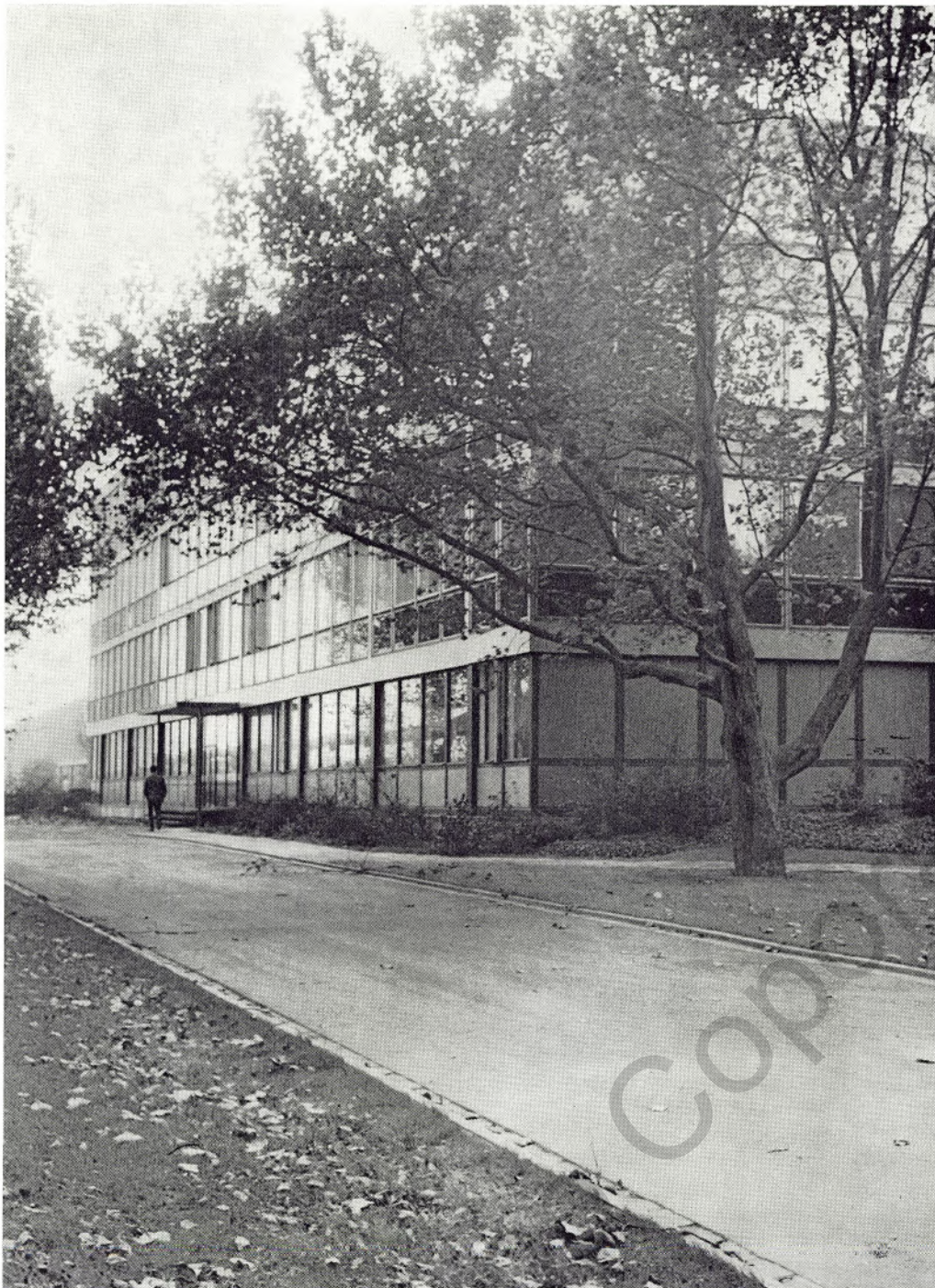
NUR NOCH VOM „MICHEL-PARK“ HER ist seit kurzem das Ingenieurhaus an der Franz-Lenze-Straße zu erreichen. Das „Aquarium“, wie es im Volksmund seit Beginn heißt, hat sich übrigens inzwischen durch einen Umbau verändert. Im bisher ungenutzten offenen Erdgeschoß wurden Büroräume eingerichtet, die dem Mangel an Büroraum im Bereich der Neubau-Abteilung nach der Zusammenlegung der Hamborner und Ruhrorter Neubau- und Bau-Abteilungen abhelfen
