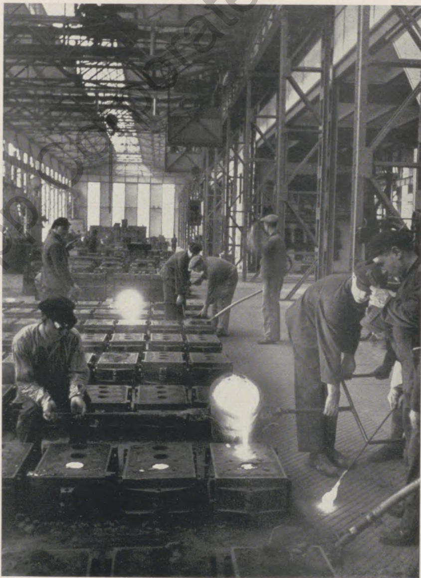
Bild 1: Gießen von Oerstit-Dauermagneten in unserem Werk Bochum
