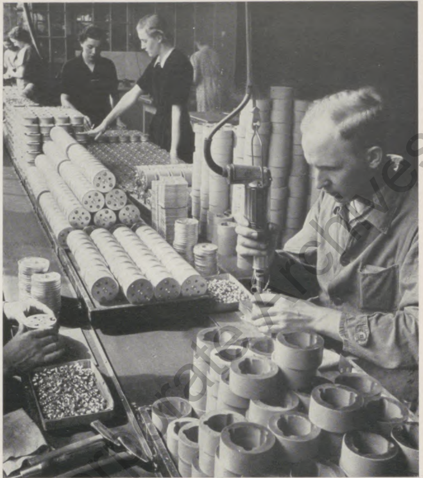
Bild 3: Zusammenbau von Oerstit-Dauremagneten
