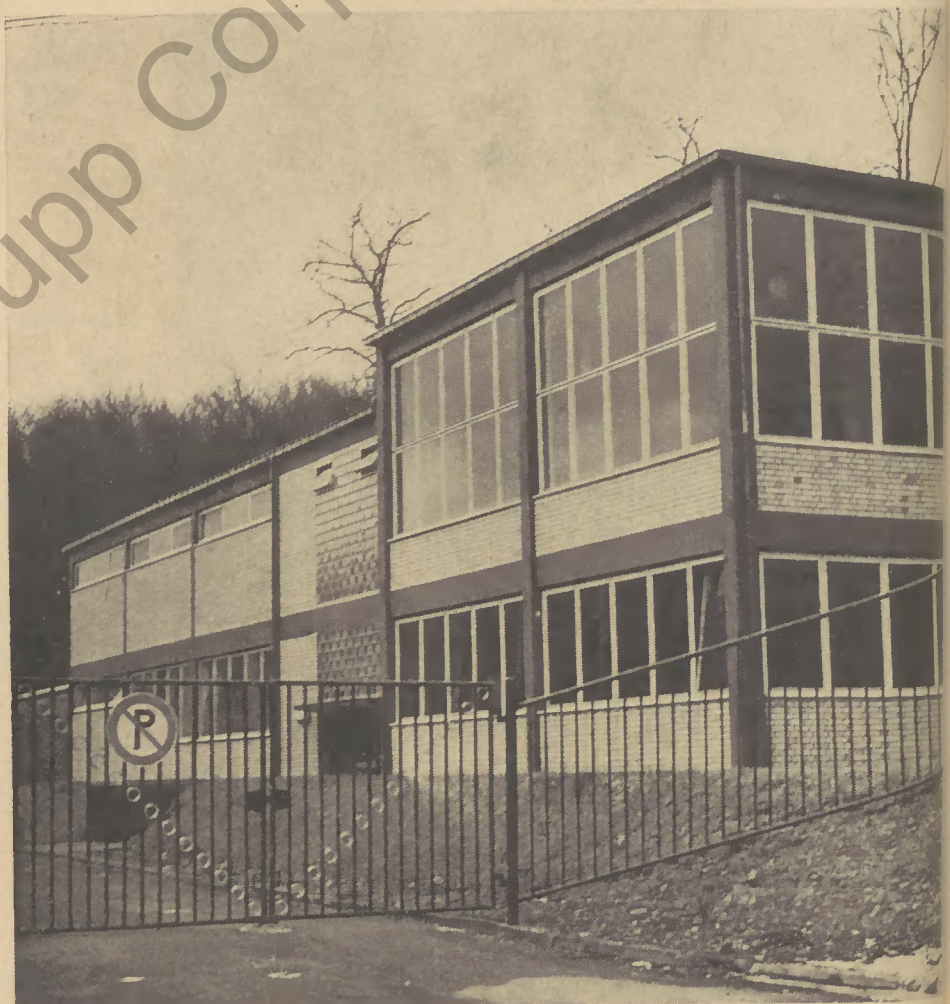
Das von der Bauabteilung Reisholz im Jahre 1965 erstellte großzügige Sozialgebäude mit Aufenthalts- und Umkleideräumen, Waschgelegenheiten und Toiletten liegt am Rande des Werksgeländes, unmittelbar angrenzend an einen herrlichen Buchenhochwald.
