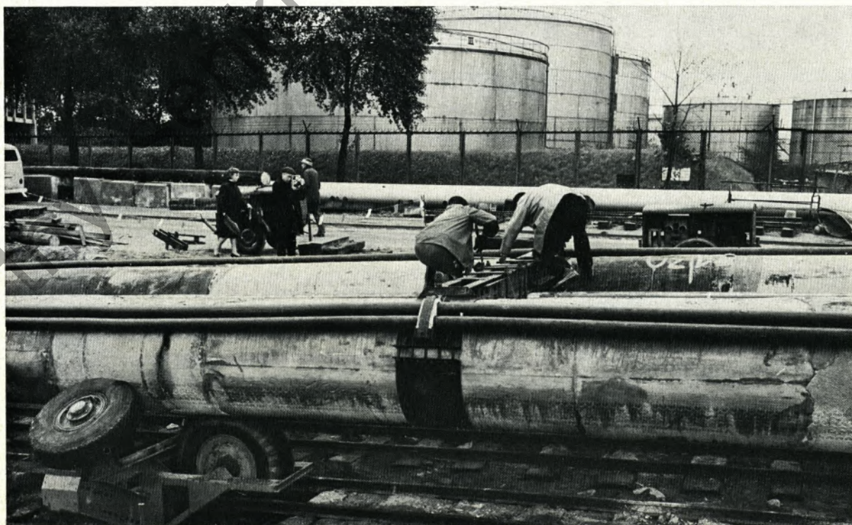
Unsere Aufnahme zeigt das Zusammenpassen der Dükerstränge sowie das Verschweißen ihrer Rohrenden, bevor der Düker in seiner ganzen Länge durch die Elbe gezogen wurde.
