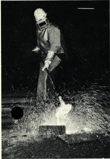
Probeentnahme am Elektroofen im SM-Stahlwerk Mülheim.
