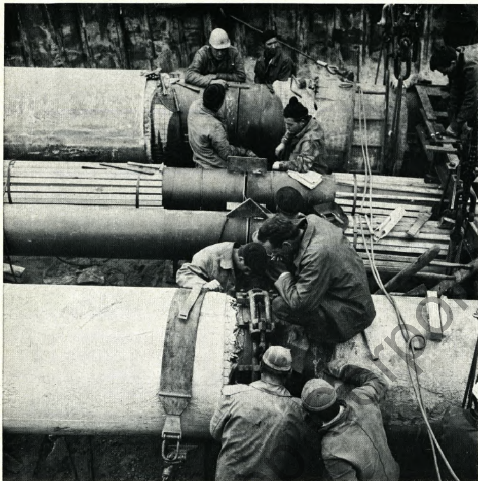
Unsere Aufnahme zeigt das Zusammenpassen der Dükerstränge sowie das Verschweißen ihrer Rohrenden, bevor der Düker in seiner ganzen Länge durch die Elbe gezogen wurde.
