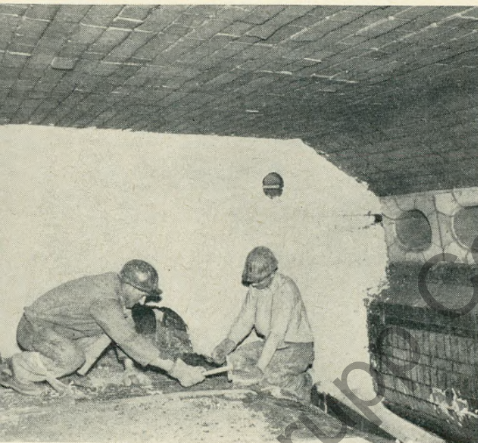
Instandsetzung des ff. Mauerwerks in einem Stoßofen
