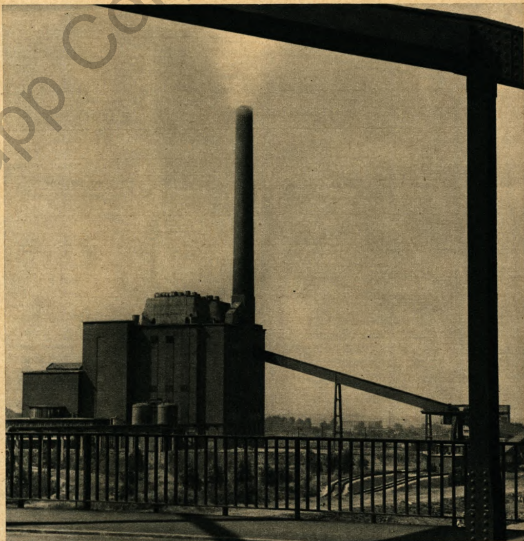
► Das neue Kraftwerk Emscher versorgt die Altenessener Schachtanlagen mit Strom, Dampf und Preßluft
