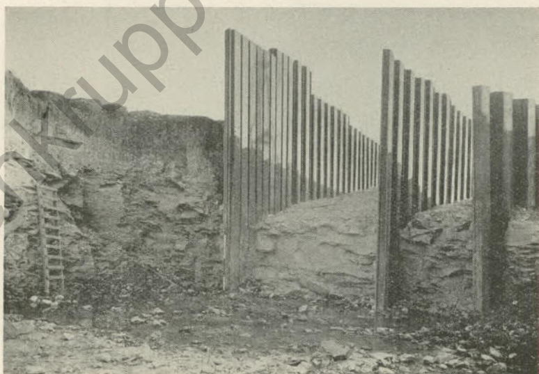
Abb. 10. Rammung in Felsboden
