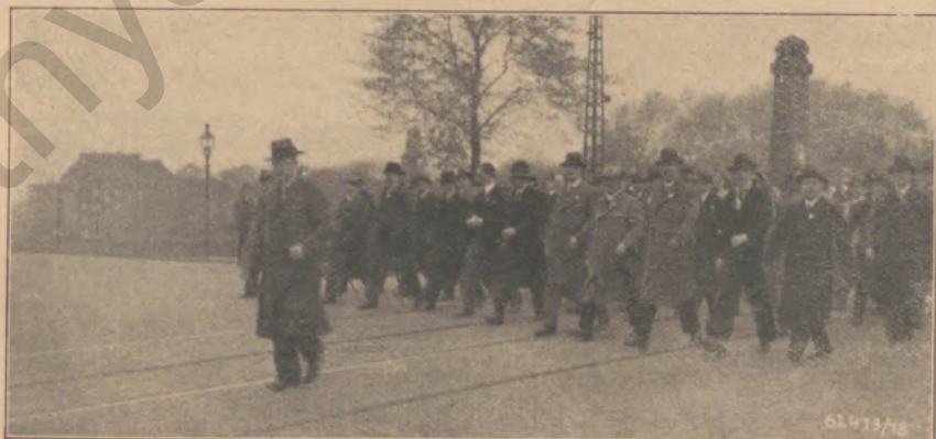
Die Verwaltung an der Möllerbrücke
