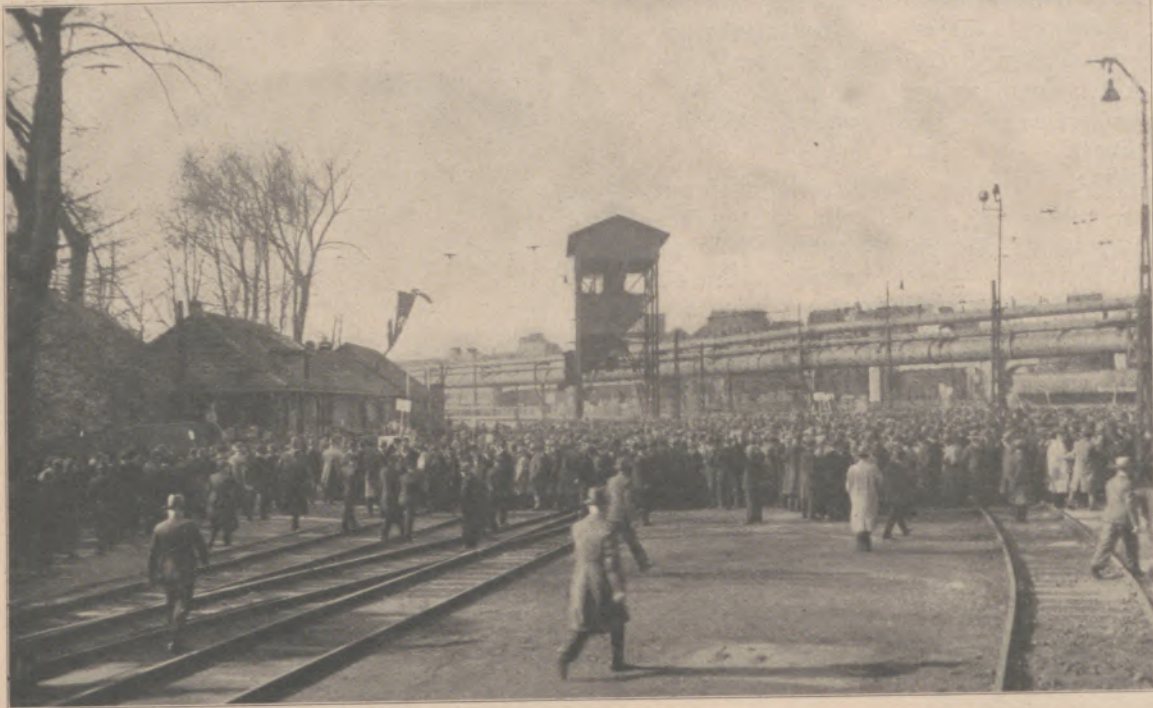
Man eilt zum Aufstellungsplatz vor der Lademästerei des Werkes Hörde Lichtbild: Benning, Hörde
