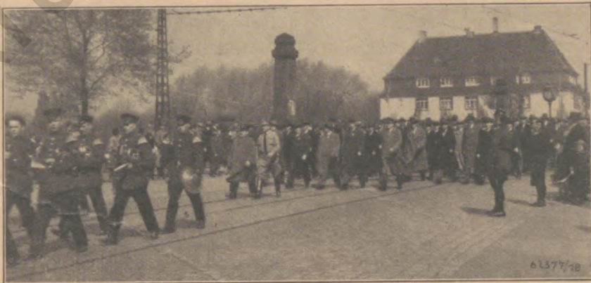
Auf der Möllerbrücke Aufnahme: Rohrbach
