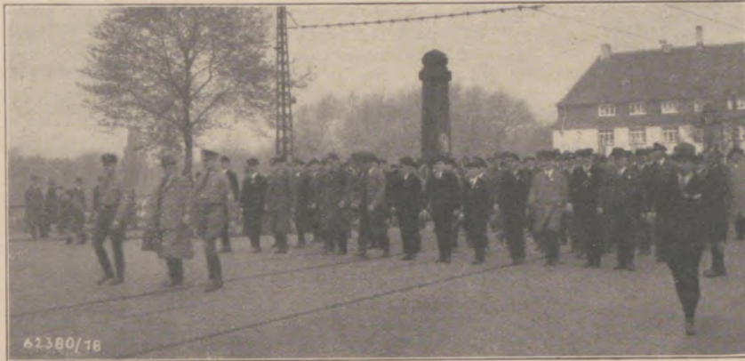
Auf der Möllerbrücke Aufnahme: Rohrbach
