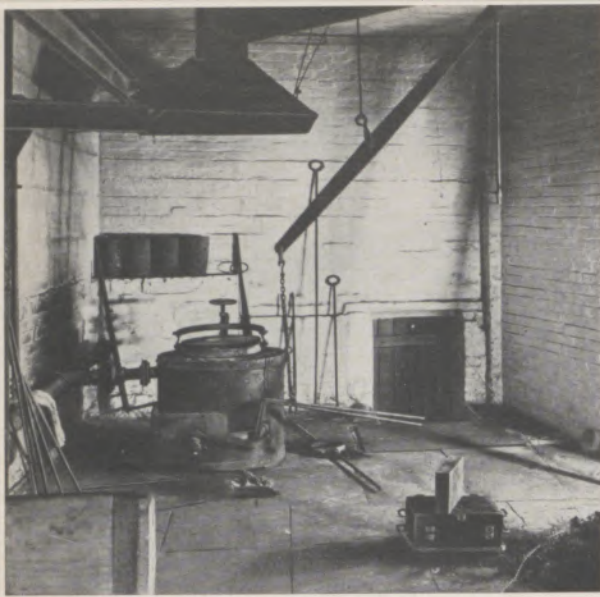
Abb. 1 Ölgefeuerter Tiegelofen in der Versuchsanstalt, 1929
