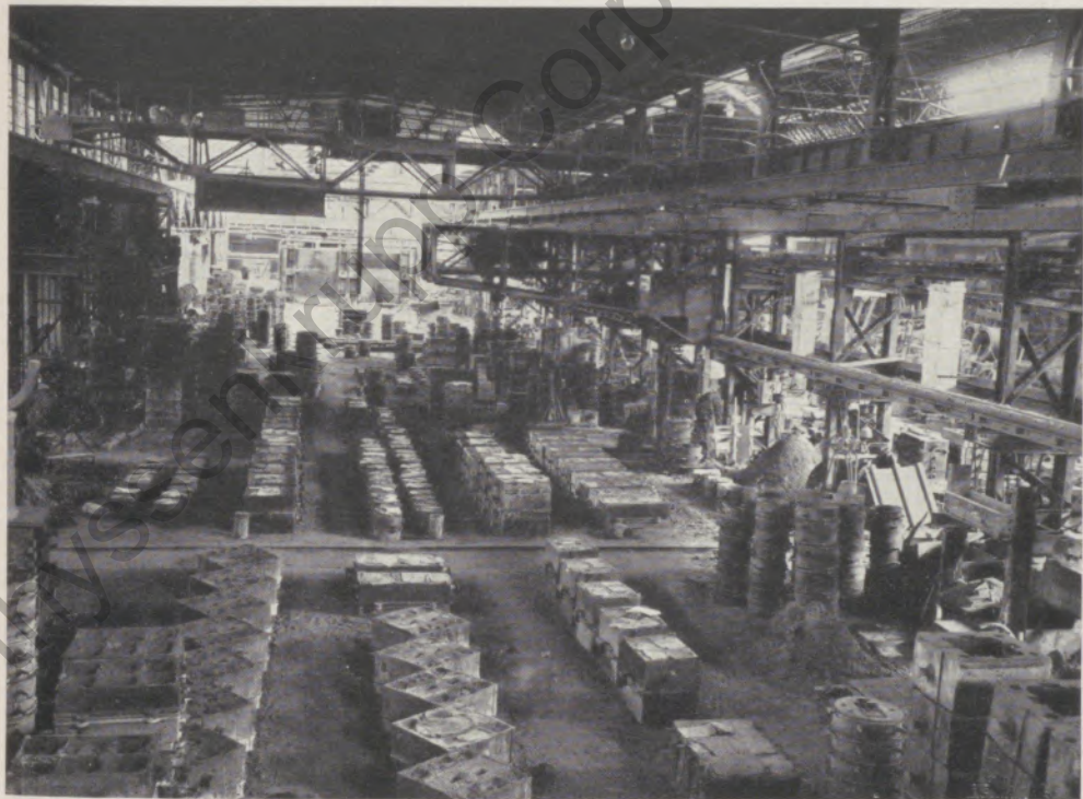
Blick in die kleine Formereihalle
