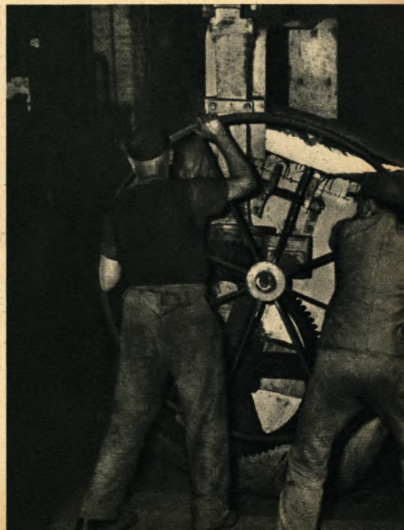
4. Konstrukteur, Modellschreiner und Former müssen Präzisionsarbeit geleistet haben, damit in der Gießerei das Maschinenteil sauber gegossen werden kann. Hier sind zwei Mitarbeiter der Maschinenfabrik Deutschland dabei, das flüssige Eisen in die Form zu gießen.
