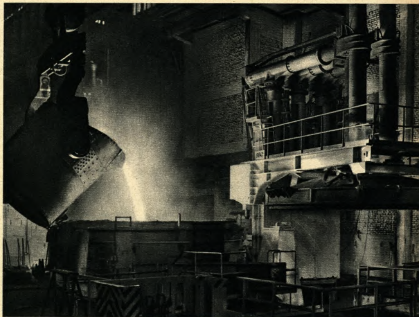
Hier wird der Elektroofen mit flüssigem Thomas-Roheisen aus dem Thomaswerk gefüllt. Der Ofendeckel ist ausgeschwenkt.
