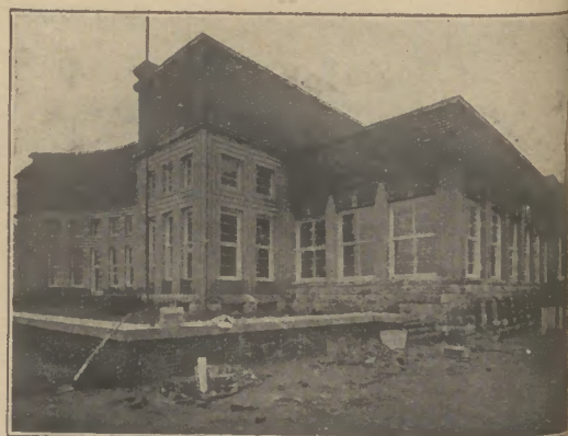
Das Rheinterassenrestaurant vor der Fertigstellung
