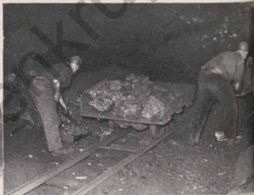
Wegfüllen des gewonnenen Erzes auf dem Abbau
