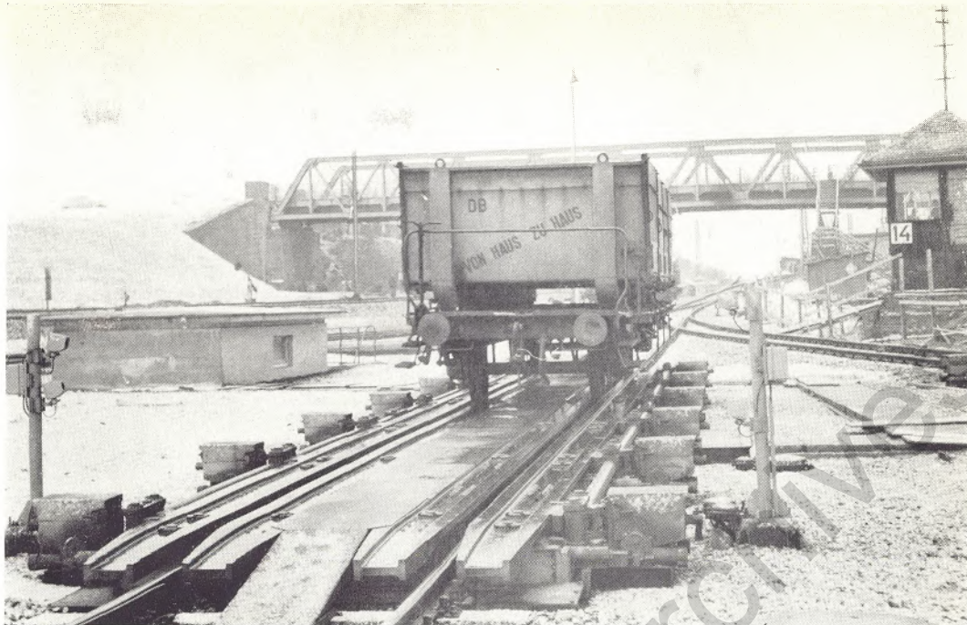
Auf der 18 Meter langen Thyssen-Gleisbremse wird auch im Rangierbahnhof Kornwestheim jeder Güterwagen mit der elektronisch gesteuerten Geschwindigkeitsmessung selbsttätig gebremst
