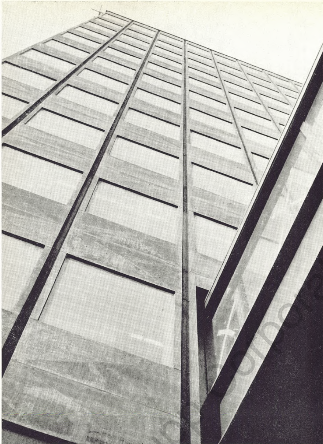
DAS HOCHHAUS FÜR DIE HAUPTVERWALTUNG an der Kaiser-Wilhelm-Straße geht der Vollendung entgegen
