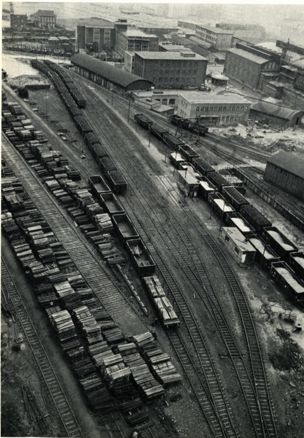
Die alte Bahnhofs-Anlage „Berg“, die, mitten im Werk gelegen, Produktionsraum beanspruchte. Im Hintergrund der Neubau der Wärmestelle, das Umkleidehaus 1 und das erweiterte „Haus der Technik“ [Siehe auch Seite 7].
