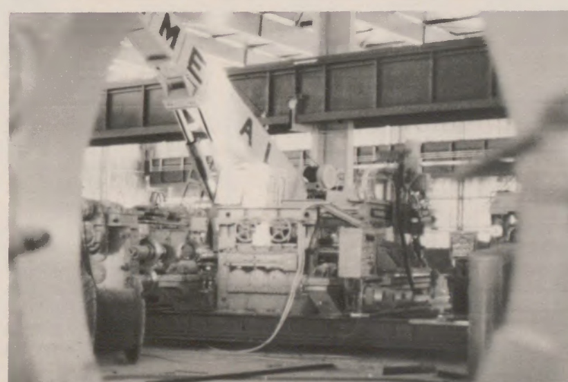
Das Spiralrohrwerk entsteht – zuerst die Hallenkonstruktion, dann der Einbau der Maschinen
