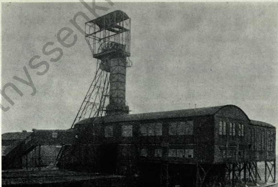
Schacht Rönsberghof mit Sieberei als selbständiger Förderschacht.
