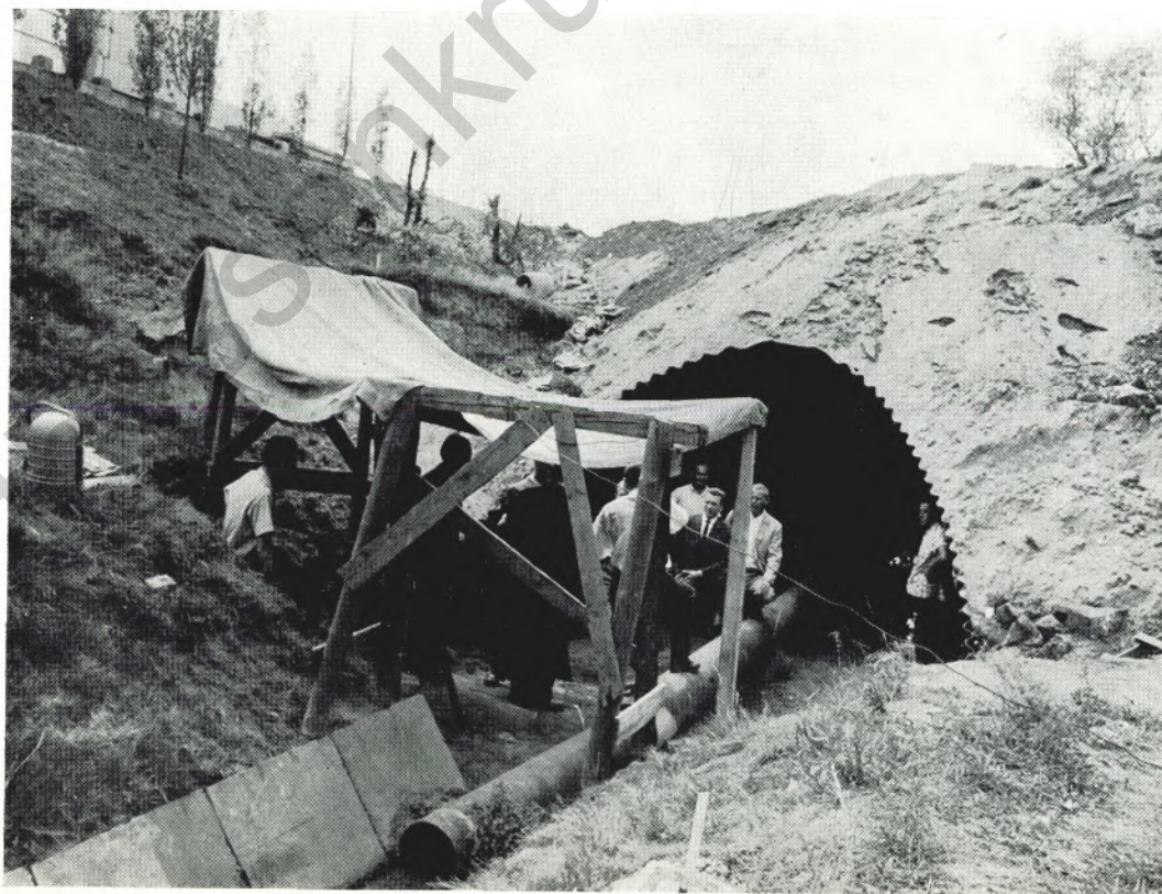
Bei der Belastungsprobe — Blick in den Ausgang des Armco-Thyssen-Durchlasses
