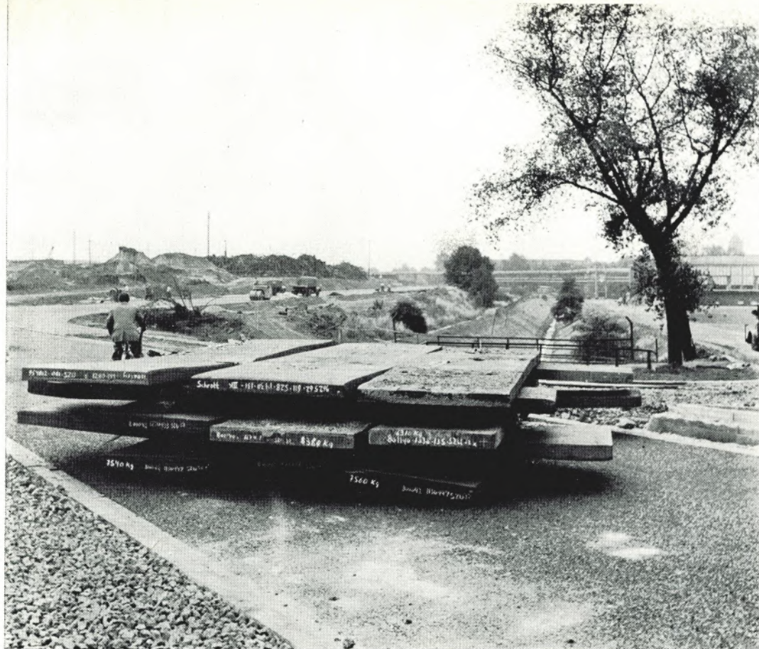
90 Tonnen Brammen belasteten den Durchlaß unter der neuen Werksstraße
