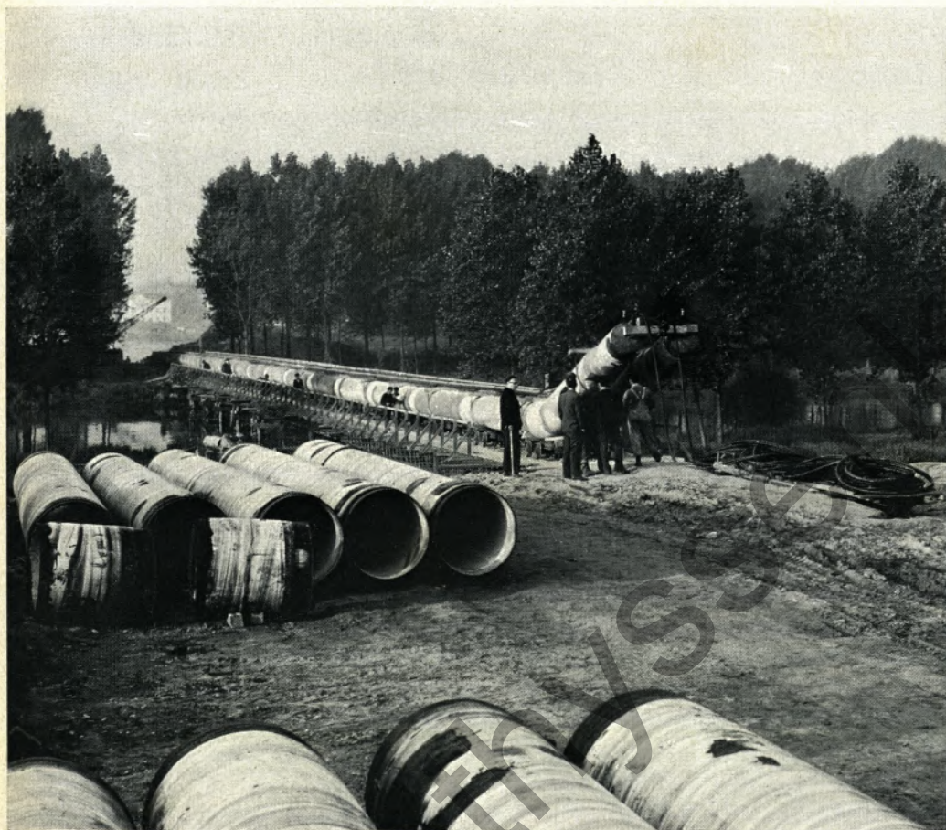
Links oben: Über eine Länge von 340 m senkrecht zum Rhein schiebt sich der Düker zum Flußbett. Rechts oben: Zur automatischen Fernsteuerung der Pumpen und Schieber, zur Messung der Fließgeschwindigkeit und der vorhandenen Wassermenge wird längs der Rohrleitung ein Telefon- und Schaltkabel verlegt. Auf der Dükerstrecke wird dieses Kabel in kunststoffumhüllten Schutzrohren durch den Rhein geführt. Unten von l. nach r.: Der Düker wird in seiner ganzen Länge an Land auf kleine Feldbahnwagen montiert. — Während der Düker mittels schwerer Kabelwinden durch den Rhein gezogen wird, werden die Feldbahnwagen vor dem Eintauchen mittels Kran herausgehoben. — Nur an den Rheinufern kann man nach dem Einziehen des Dükers noch seine Rohrenden erblicken.
