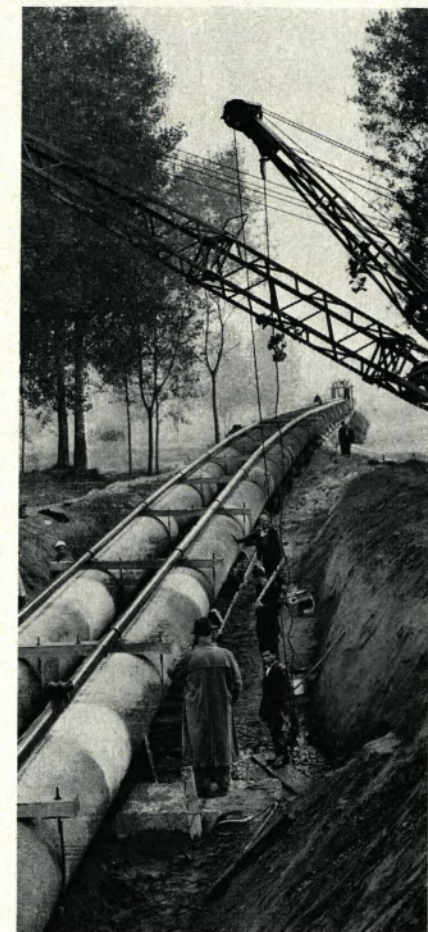
Links oben: Über eine Länge von 340 m senkrecht zum Rhein schiebt sich der Düker zum Flußbett. Rechts oben: Zur automatischen Fernsteuerung der Pumpen und Schieber, zur Messung der Fließgeschwindigkeit und der vorhandenen Wassermenge wird längs der Rohrleitung ein Telefon- und Schaltkabel verlegt. Auf der Dükerstrecke wird dieses Kabel in kunststoffumhüllten Schutzrohren durch den Rhein geführt. Unten von l. nach r.: Der Düker wird in seiner ganzen Länge an Land auf kleine Feldbahnwagen montiert. — Während der Düker mittels schwerer Kabelwinden durch den Rhein gezogen wird, werden die Feldbahnwagen vor dem Eintauchen mittels Kran herausgehoben. — Nur an den Rheinufern kann man nach dem Einziehen des Dükers noch seine Rohrenden erblicken.
