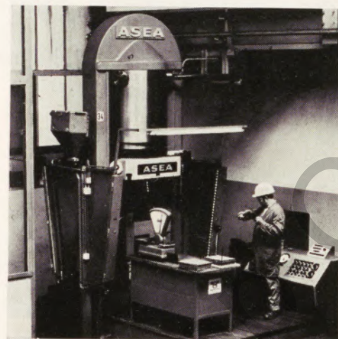
An dieser Hydropresse sind beidseitig jeweils 36 Lichtschrankenpaare installiert; bei dem großen Arbeitshub der Presse ist dies auch erforderlich.
