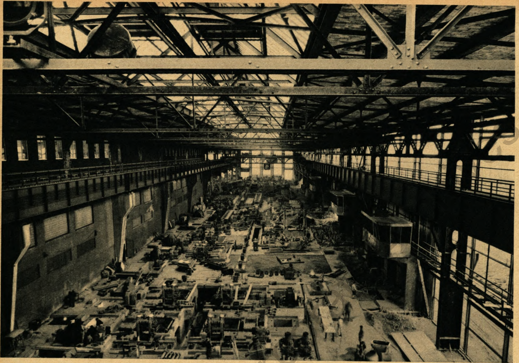
▲ Die Montageteile der Walzgerüste und Maschinen liegen in der Halle zum Zusammenbau bereit
