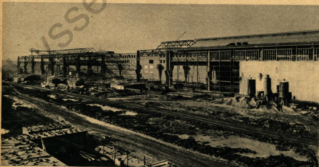
◀ Die neue Feineisenstraße während des Aufbaus. Schlamm und Regen erschwerten die Arbeiten
