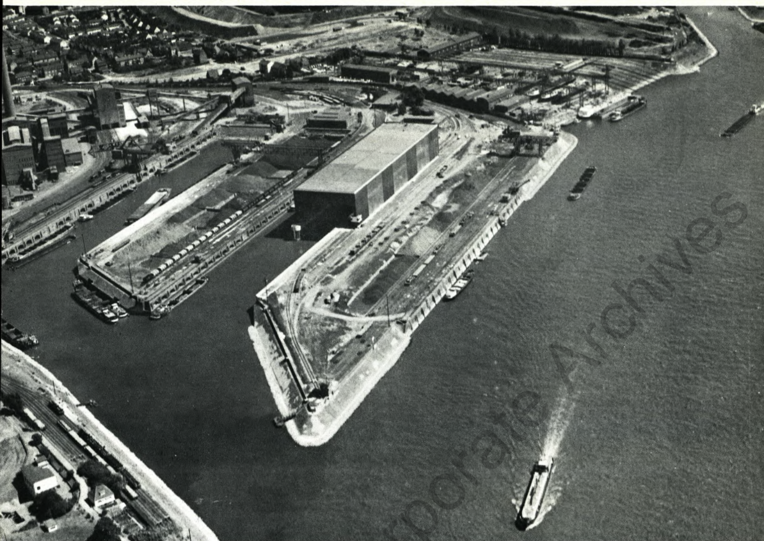
So präsentiert sich der Hafen Walsum-Süd heute. Dominierendes Wahrzeichen ist die 1971 errichtete Walzstahlverladehalle, die für den witterungsunabhängigen Umschlag von Produkten der ATH und von TN gebaut wurde.
