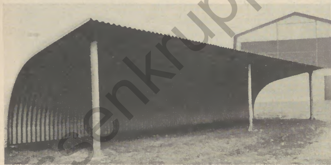
Parküberdachung für Autos, Motorräder und Mopeds
