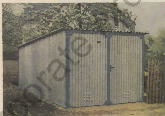
Pultdachgarage aus feuerverzinkten Stahlwellblechen
