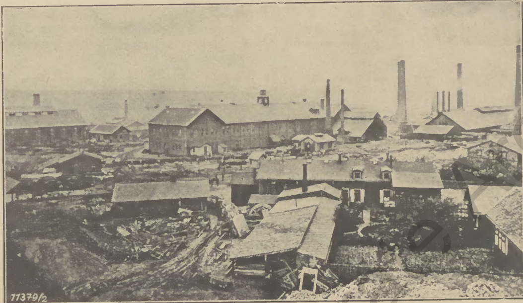
Abb. 1: Die Henrichshütte vor etwa 50 Jahren vom Hochofen aus aufgenommen. Vorn die Rückseite der Kantine und der Zimmerplatz. Der Anbau mit dem Ramin am Verwaltungsgebäude enthielt die Fassonschmiede. Rechts davon die Tackfabrik, das erhöhte Dach dahinter gehörte zum Puddelwerk, ganz links die Eisengießerei
