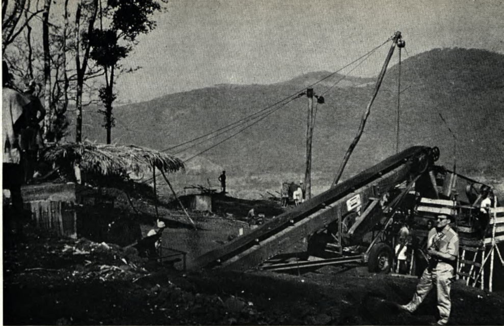
In kurzer Zeit wurden an dieser Versuchssiebanlage mitten im afrikanischen Busch fast 3000 Tonnen handgewonnenes Erz abgeleitet. — Vorn rechts Dipl.-Bergingenieur Feik von der deutschen Reisegruppe
