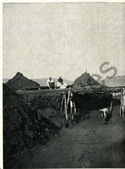
Diese Verladeanlage wurde mit landeseigenen Mitteln gebaut, mit Baumstämmen und Schlingpflanzen
