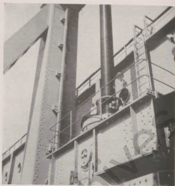
28 Meter lange Spindel vom Schiffshebewerk Magdeburg-Rothensee
