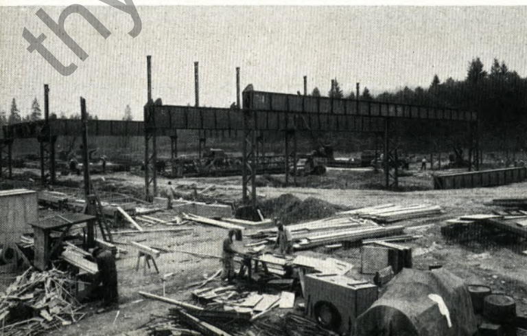
In Port Moody/Vancouver wurde der Aufbau der neuen Werkhallen sofort nach dem Löschen begonnen. Stahlrohrkonstruktionen und Betonständer wuchsen Tag für Tag aus dem Boden
