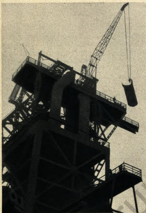
▲ Der Abbruch der Gasabzugsleitungen und des Ofenpanzers ist in vollem Gange: ein auf der Übergicht aufgesetzter Auslegerkran nimmt ein Rohrteil ab
