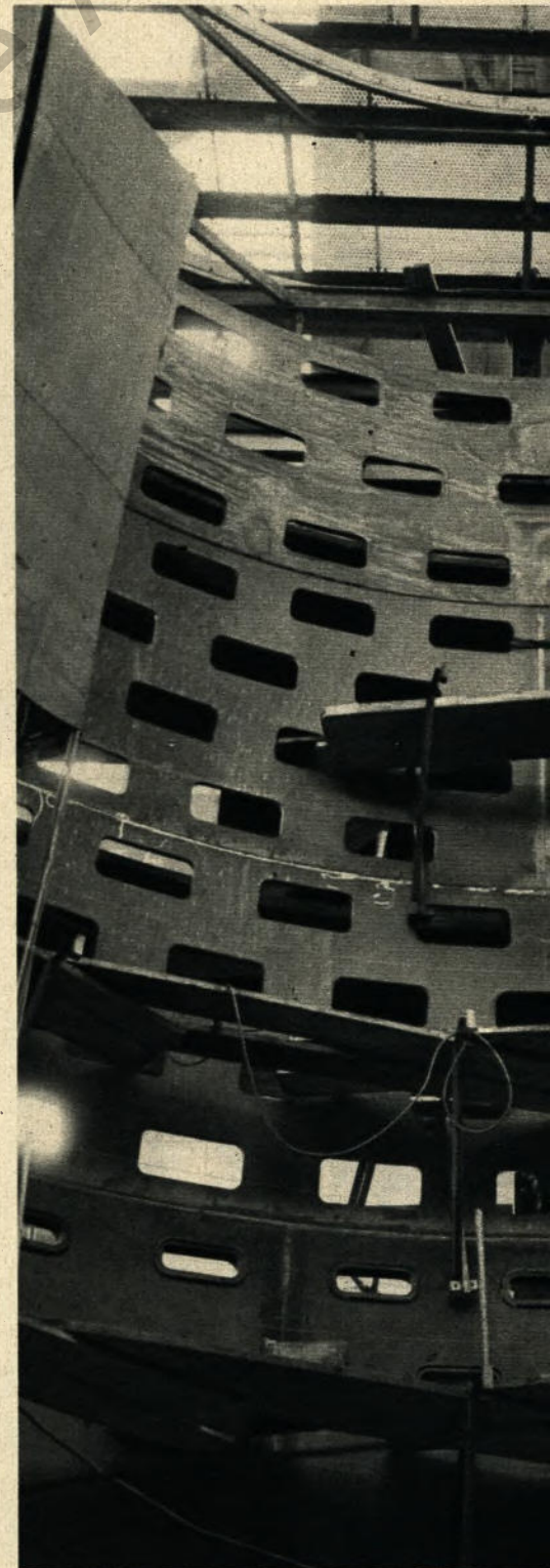
▲ Der Ofenpanzer ist verschwunden; Ofengerüst und Schrägaufzugsbrücke werden nun instand gesetzt, während zugleich ein neues Ofenfundament entsteht
