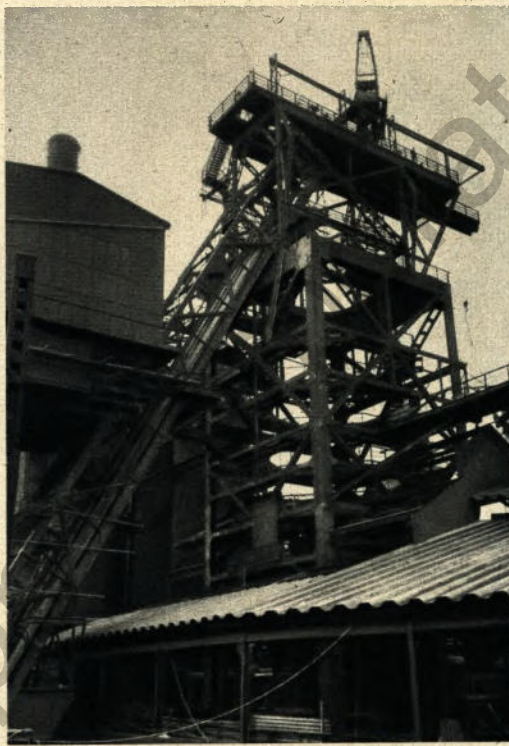
▲ Der Ofenpanzer ist verschwunden; Ofengerüst und Schrägaufzugsbrücke werden nun instand gesetzt, während zugleich ein neues Ofenfundament entsteht
