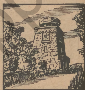
Der Bismarkturm auf dem Seilerkopf.
