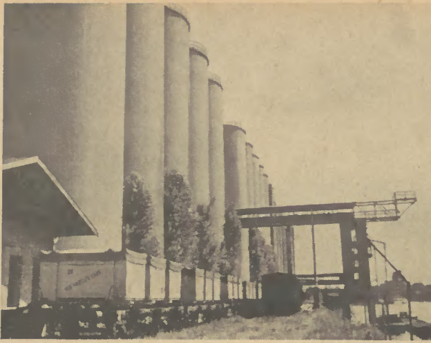
Getreidesilos mit Baustahlgewebe bewehrt
