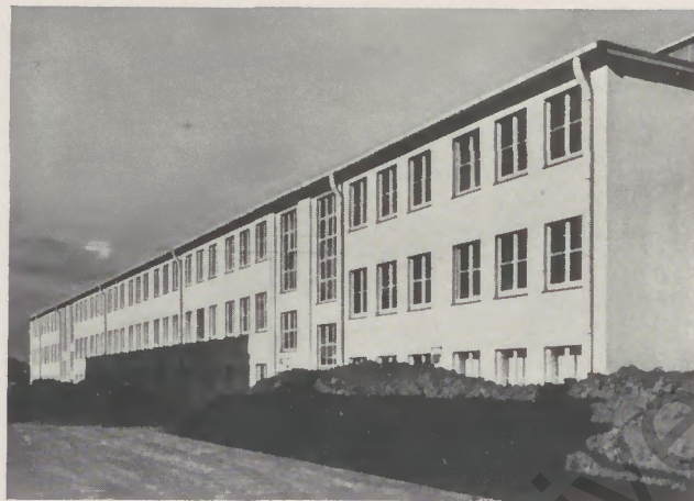
Die neue mechanische Werkstätte, Büroteil
