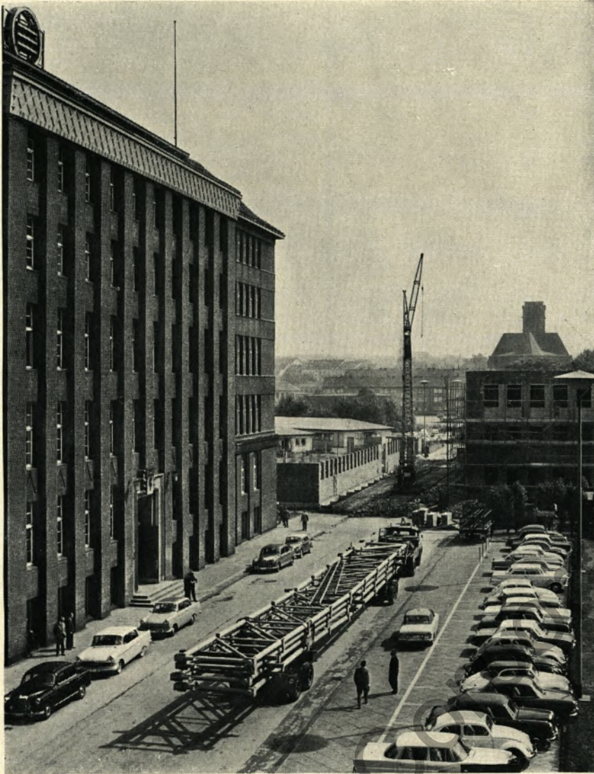
Die Stahlkonstruktion für das Dach der Werkstatt unseres Forschungsinstitutes ist im Stahlbau des Werkes Thyssen hergestellt worden. Jeder der acht Träger besitzt eine Spannweite von 30 Metern und wiegt etwa 3,2 Tonnen. Auf einem Spezialwagen werden die ersten Träger zur Baustelle neben dem Verwaltungsgebäude transportiert.
