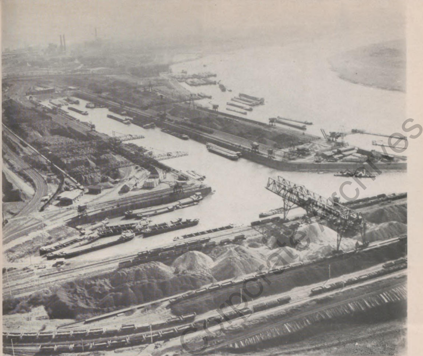
Diese Luftaufnahme gibt einen guten Überblick über die Anlagen des Hafens Schwelgern. Im Vordergrund der Stichhafen mit dem Waggonkipper. Die Bandförderanlage beginnt bei den zwei Portalkränen am Gegenufer. Dahinter das Schifferheim und der Parallelhafen mit den Verladebrücken und Portalkränen, rechts der Rhein mit dem Ufer von Baerl. Im Hintergrund sind (links) die beiden Schornsteine des Kraftwerkes Hamborn zu sehen; der Schornstein daneben gehört zur Sinteranlage der Hütte
