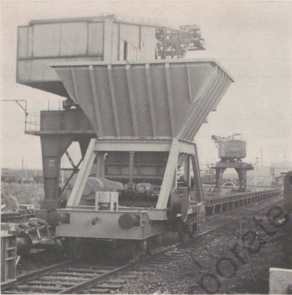
Die Bandförderanlage für Erze beginnt am Stichhafen. Hier geben die beiden Krane die Erze über zwei fahrbare Aufgabebunker auf das Band
