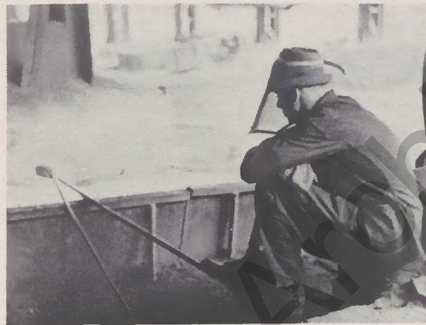
Trocknen des Probelöffels während des Hochofenabstichs
