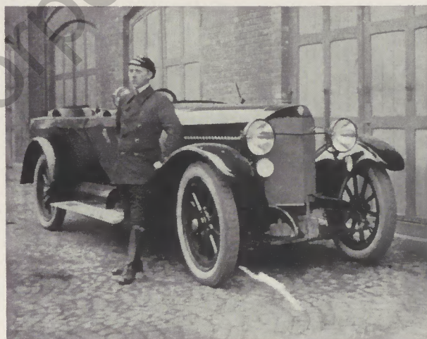
Ein ganz „moderner“ Mercedes-Benz, der 6-Zylinder 16/50er aus dem Jahre 1921. Neueste technische Errungenschaften: Anlasser und elektrische Beleuchtung. Das erste Modell dieser Art im Siegerland.
