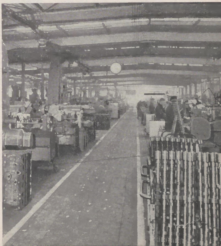
Bild rechts: Links die Fertigungsstraße für Kurbelgehäuse Motor 522, rechts die Nockenwellenstraße.
