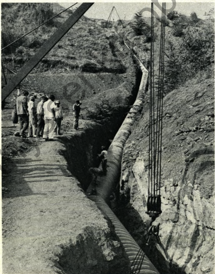
Ein fertigverschweißter Leitungsabschnitt von 250 m Länge wird in einen Rohrgraben abgesenkt.
