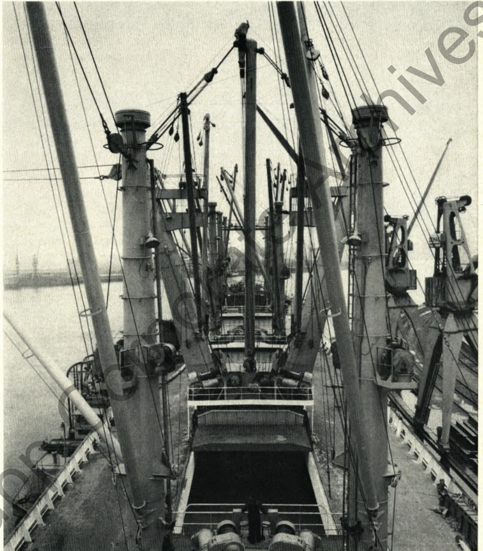
Mastenwald eines modernen Frachtschiffes, im Vordergrund eine Ladeluke und das weltberühmte Stülcken-Geschirr — MS „Borussia“, eines der sieben schnelllaufenden Frachtschiffe, die Blohm + Voss für die HAPAG baute, auf der Probefahrt, der letzten Phase vor der Schiffsübergabe.
