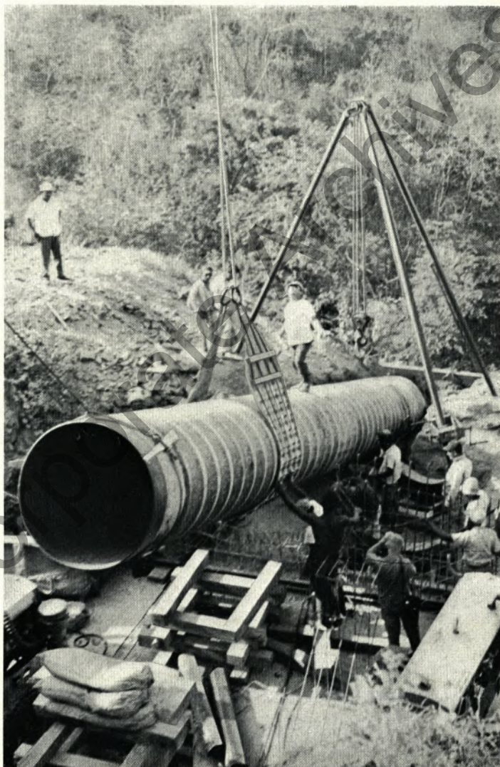
Absetzen eines Rohrstückes der Nennweite 1250 mm in einer steilen Bergstrecke.
