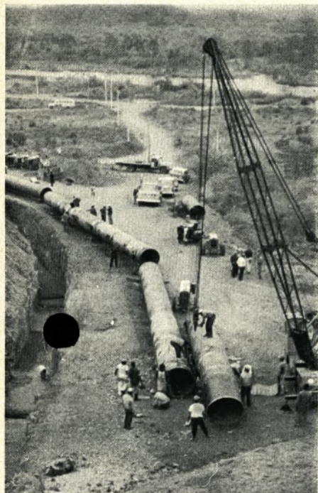
Thyssenrohr International und Stahlunion Export verlegen für die Hafenstadt Guayaquil eine neue Wasserleitung. Seite 34
