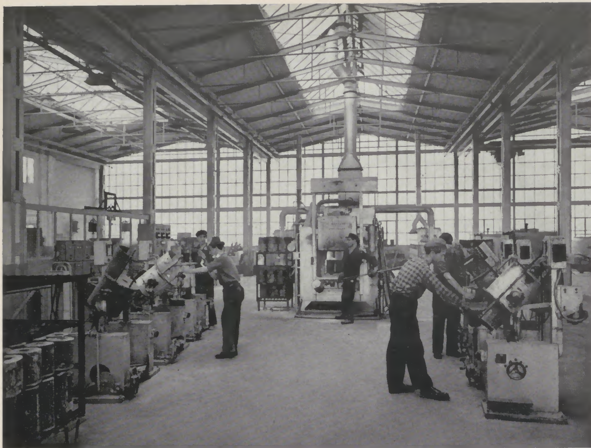
Teilansicht der Schmelzhalle mit Lichtbogenöfen, Ausschmelzöfen und Brennofen
