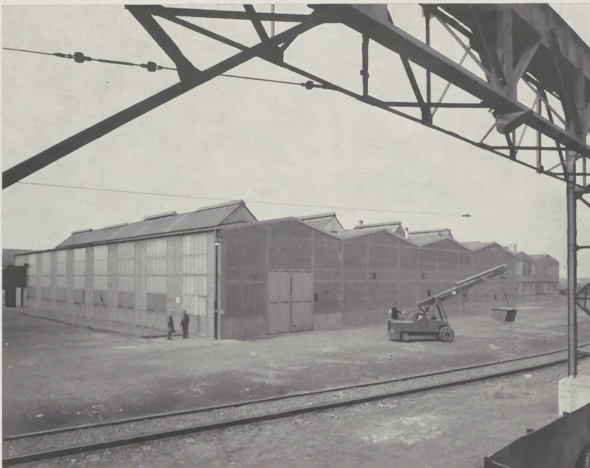
Teilansicht der Hallen, in denen die Bochumer Feingießerei untergebracht ist.
