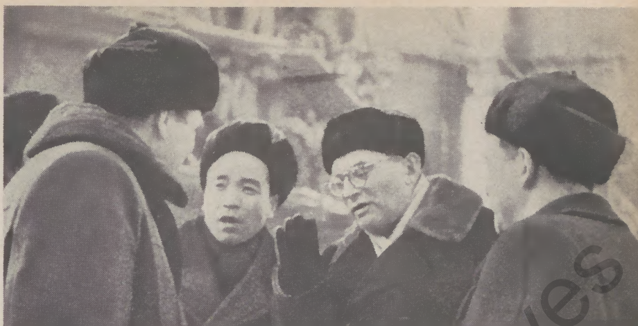
Sowjet-Spezialisten helfen beim Bau des neuen chinesischen Hüttenkombinats von Pautu in der Inneren Mongolei: Die drei Sowjet-Spezialisten N. I. Liuderspiegel (1. v. rechts) I. I. Stepanski (2. v. rechts) und L. I. Levin (1. v. links) an der Baustelle des Hochofens Nr. 1 im Gespräch mit einem chinesischen Ingenieur
