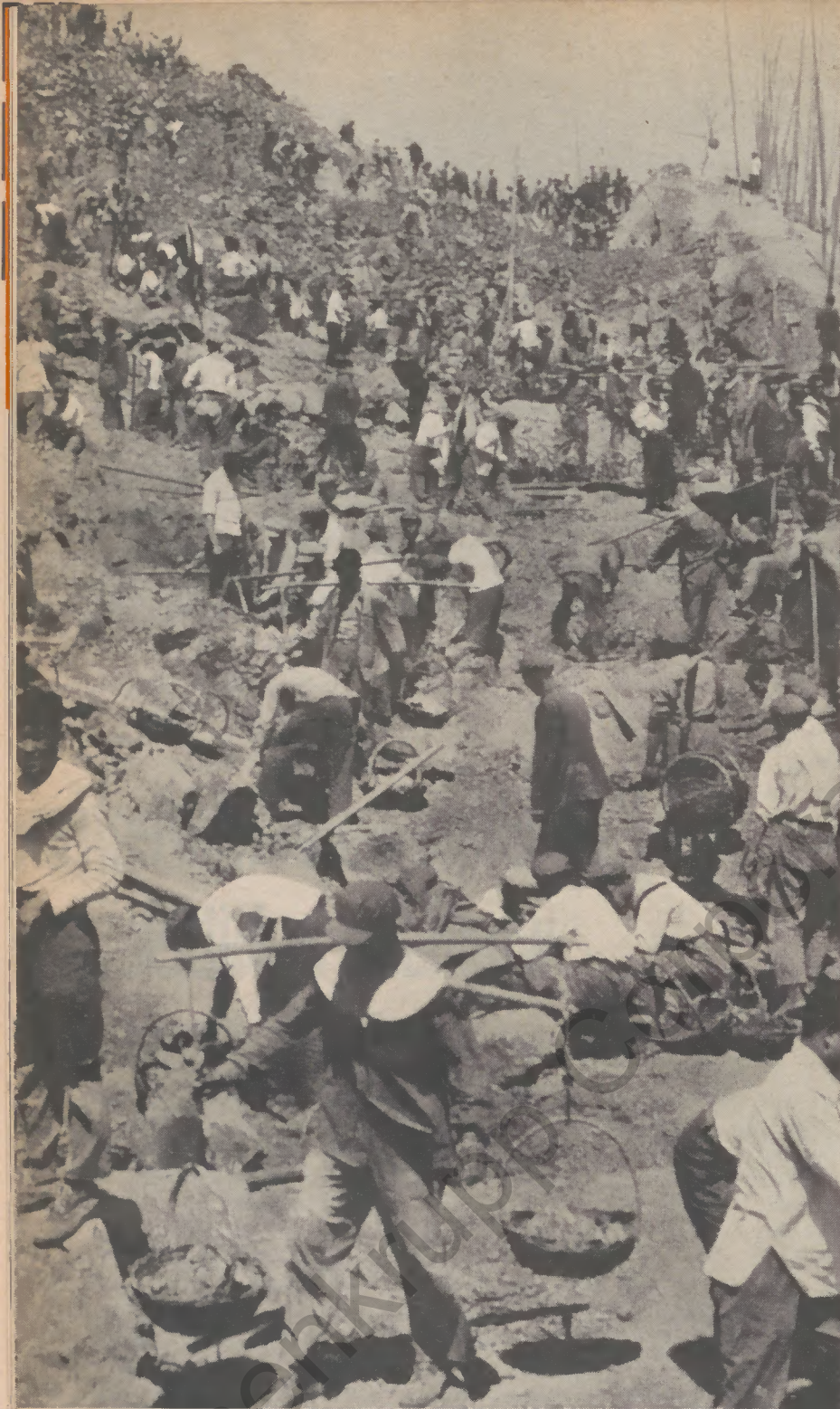
Mao Tse-Tungs Ingenieure haben — mit sowjetischer technischer Hilfe — begonnen, eins der gewaltigsten Bauprojekte durchzuführen. Westlich von Hankow wird bei einer gefährlichen Flußenge ein Damm von 300 m Höhe und 4 km Länge errichtet, für den eine in der Nähe aufgebaute Zementfabrik 20 Millionen Tonnen Zement liefern soll. Dieser Damm wird zwölfmal größer sein als der berühmte Grand Coulee-Damm der USA. Ein Kraftwerk soll die gestaute Wasserkraft ausnutzen und im Endstadium 22 Millionen Kilowatt Strom liefern Unser dpa-Bild zeigt die rotchinesische Bautechnik: wenig Maschinen, aber Tausende von Menschen, die Zement in Säcken und Steine in Körben heranschaffen
